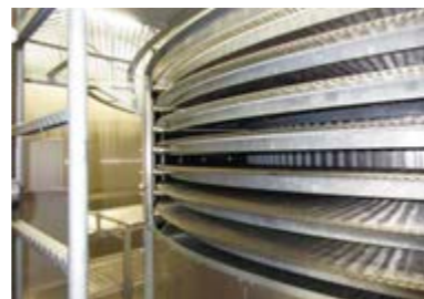
スパイラルフリーザーの内部
