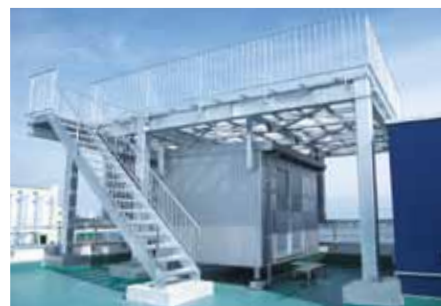
避難設備と防災倉庫
