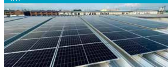
太陽光パネルの設置 (株) ジョッキ
