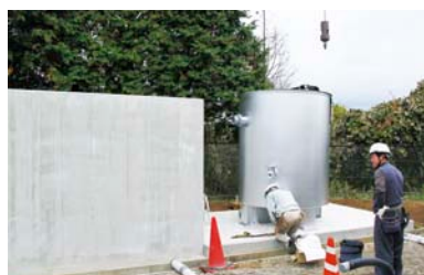
建設中の加圧浮上浄水設備 (極洋食品(株)ひたちなか工場)
