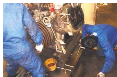
冷凍機のオーバーホール(極洋食品(株)八戸工場)
